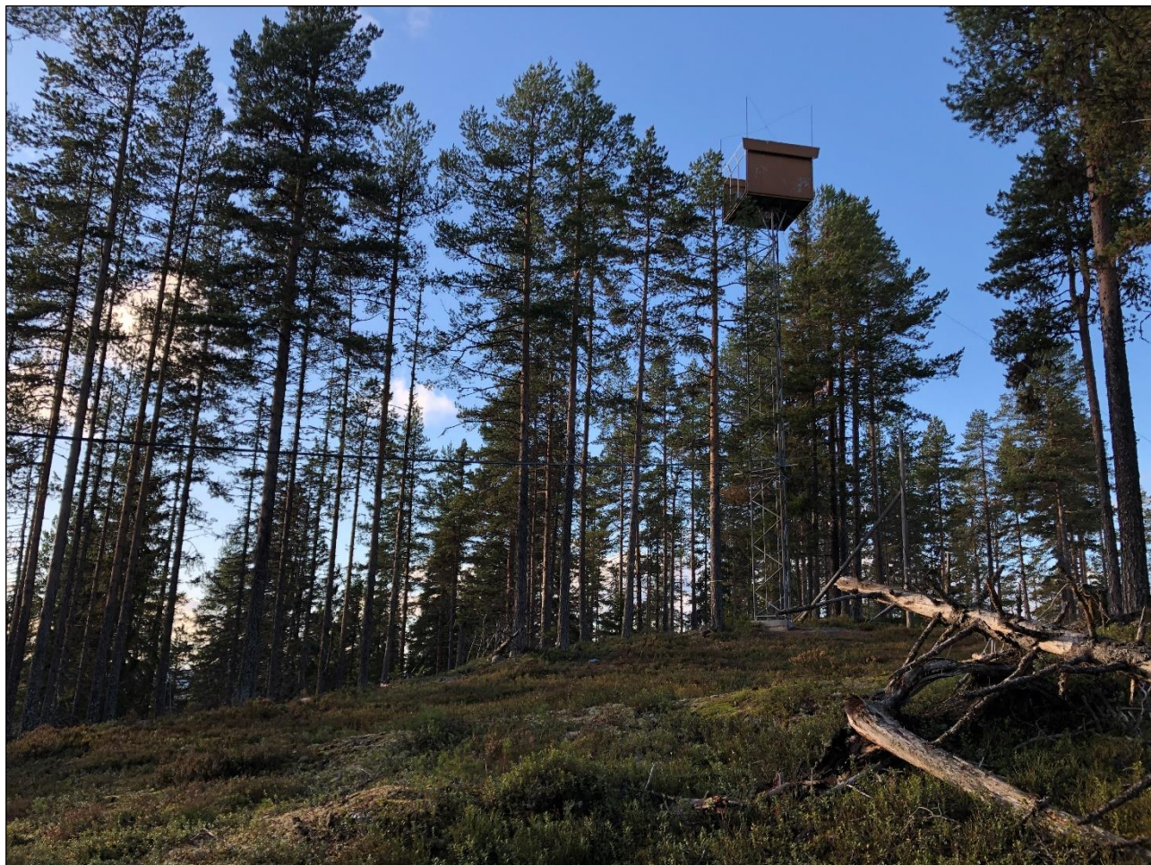
Utkikstorn med fackverks-konstruktion
